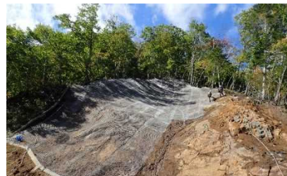
道路斜面の防災対策（国道38号 浦幌町）
