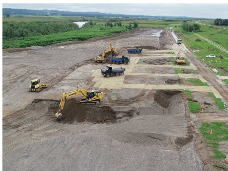
河道掘削の状況
