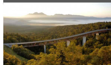
国道273号 三国峠 松見大橋の景観
