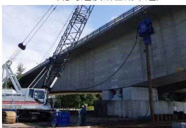
緊急輸送道路上の橋梁の耐震補強 (国道241号 平原大橋)
