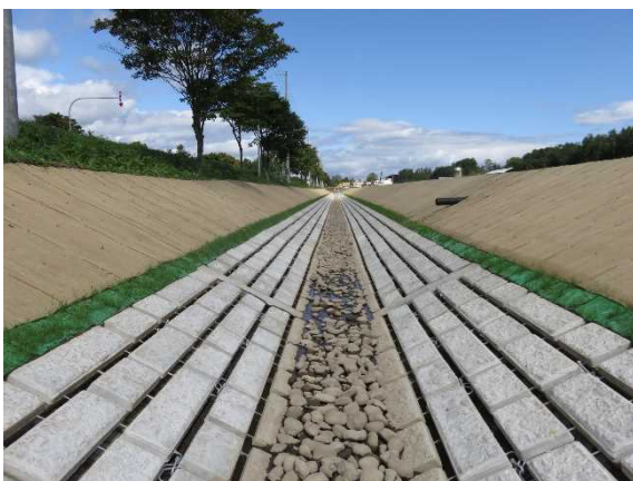
整備中の明渠排水路（上士幌北地区）
