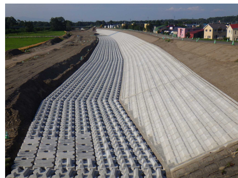
堤防保護の状況
