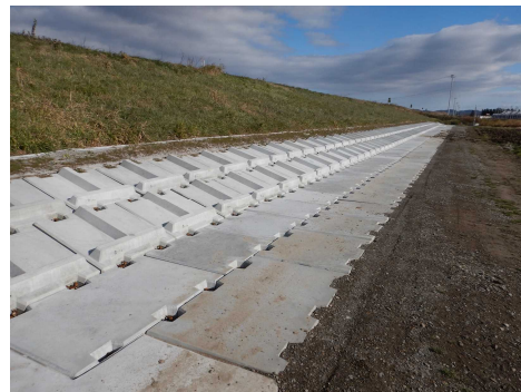
堤防法尻補強の状況
