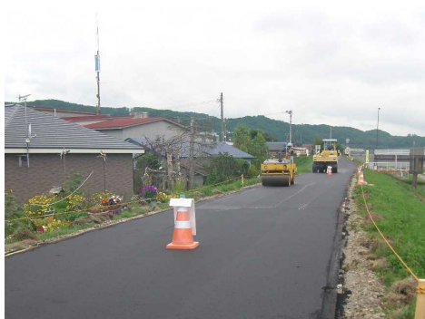
堤防天端保護の状況
