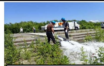
災害対策用機械操作訓練
