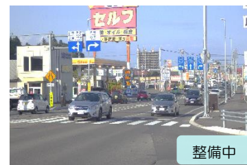
道路の防災性の向上 (音更町 国道241号) ※整備を完了した箇所から電柱を撤去中
