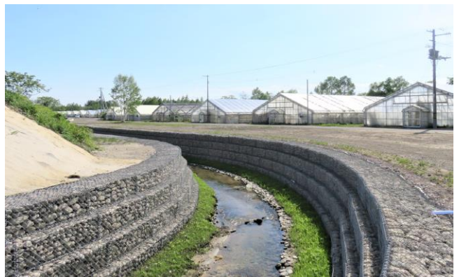
整備中の排水路（富秋士幌川下流地区）
