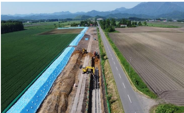
整備中の用水路（芽室川西地区）
