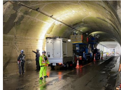
トンネルの点検状況 (国道336号 ファンベントネル)
