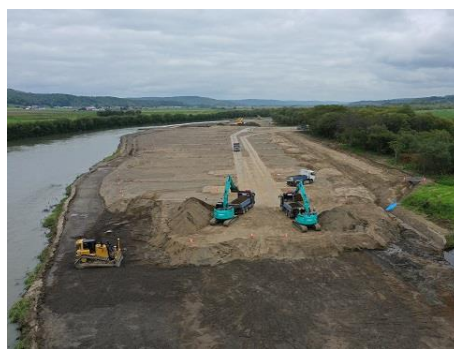
河道掘削の状況
