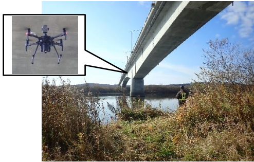
ドローンによる橋梁の点検状況 (国道336号 + 勝河口橋)
