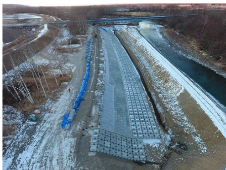
侵食対策の状況
