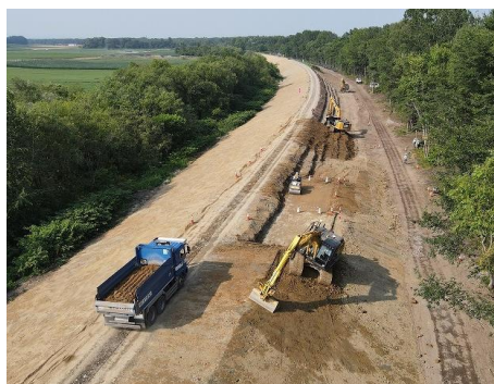
堤防整備の状況
