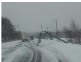
暴風雪による電柱の倒壊 (大樹町 国道336号)
