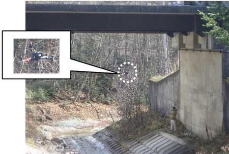
ドローンによる橋梁の点検状況
