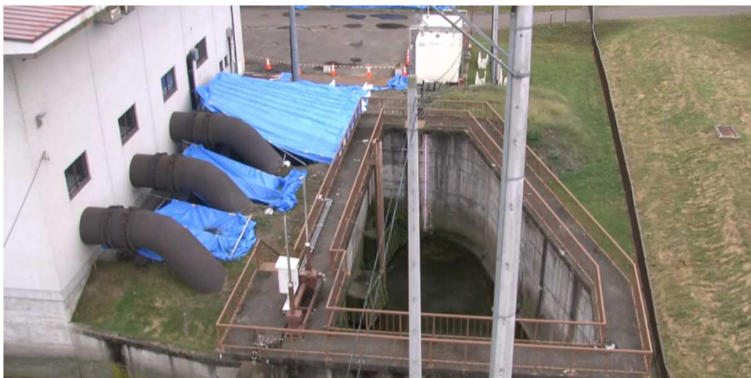
土砂撤去箇所 の 状況 (9/12撮影)
