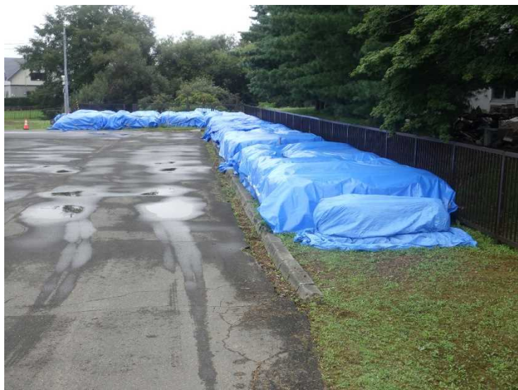
撤去土砂174袋分の仮置状況 (9/12撮影)
