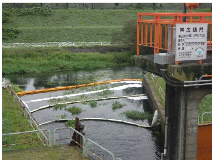
オイルフェンス設置状況 (9/12撮影)
