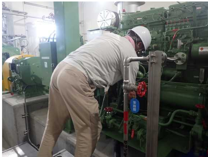
定期点検の作業状況（8/23撮影）
