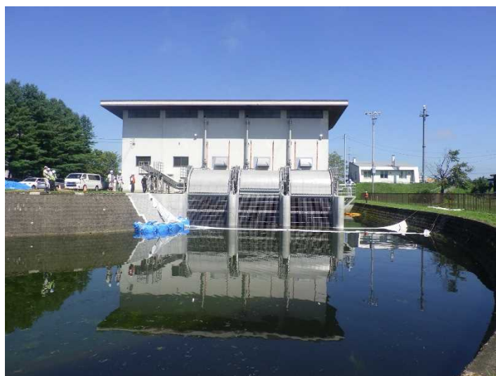
定期点検に伴う水位上昇状況（8/23撮影）
