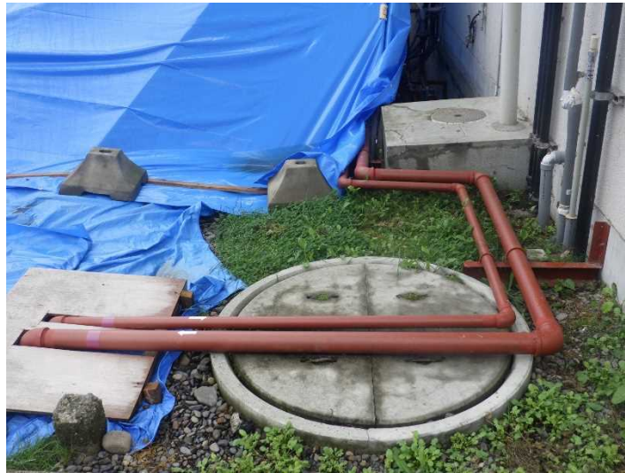
仮設燃料配管の敷設状況（9/12撮影）
