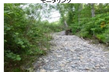
流入部掘削を行った旧流路沿いで樹木流亡・礫河原が回復し、旧流路が維持
