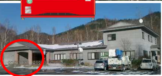
幌加除雪ステーション 入口ホール
