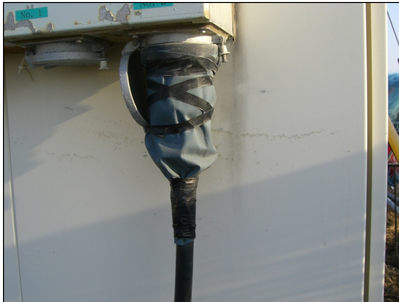
船舶給電施設の壁にゴミ付着の津波痕跡（地盤から 1.0m程度）
