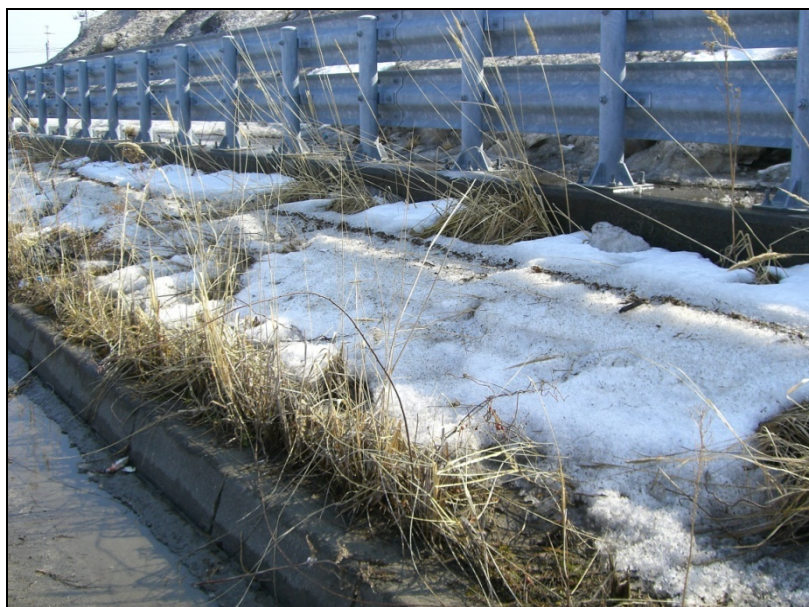
残雪に一定の高さのゴミ付着の津波痕跡（地盤から 0.5m程度）
