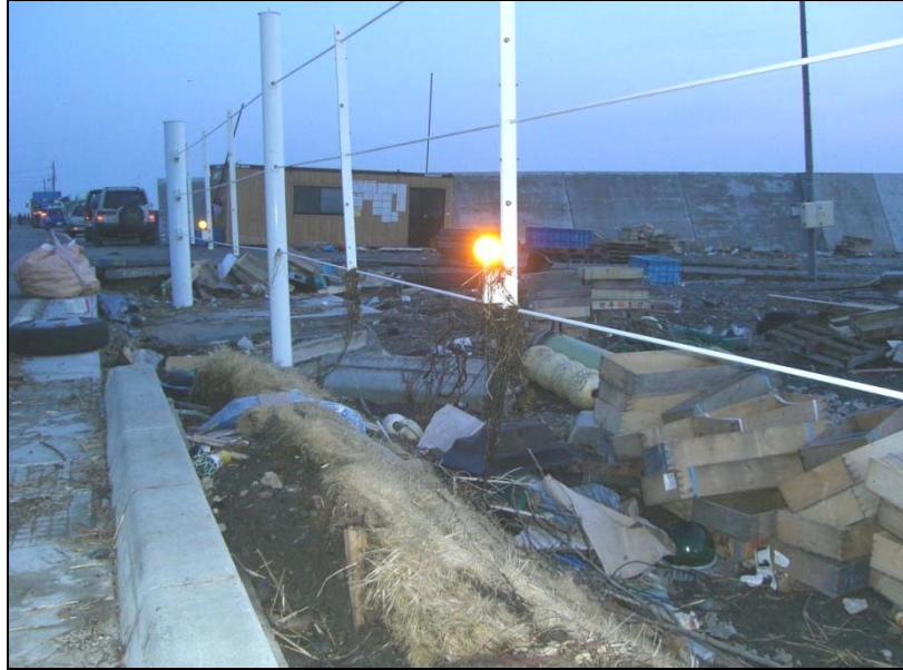
津波スクリーンの下端横ワイヤーに海藻付着（地盤から 1.0m程度）
