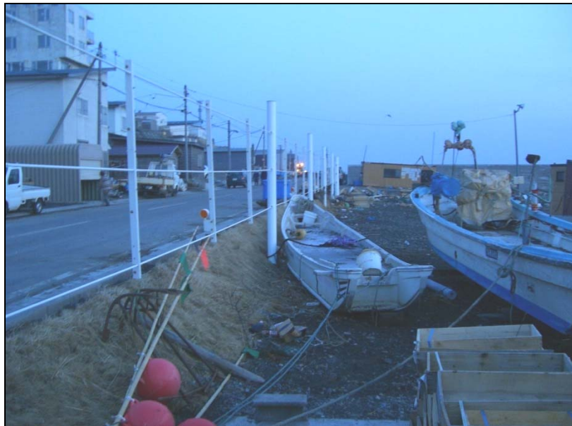
津波スクリーンが、漁船の流出を防いだ形跡
