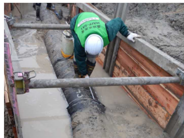
パイプラインの継目間隔の確認
