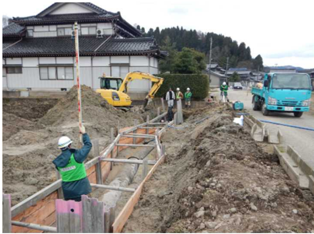
パイプラインの標高確認
