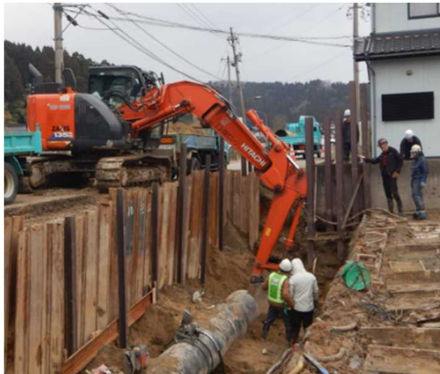
応急復旧作業（管の切断）
