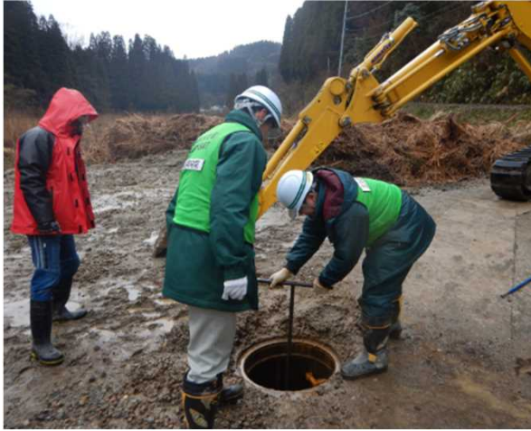
充水作業（制水弁の開操作）
