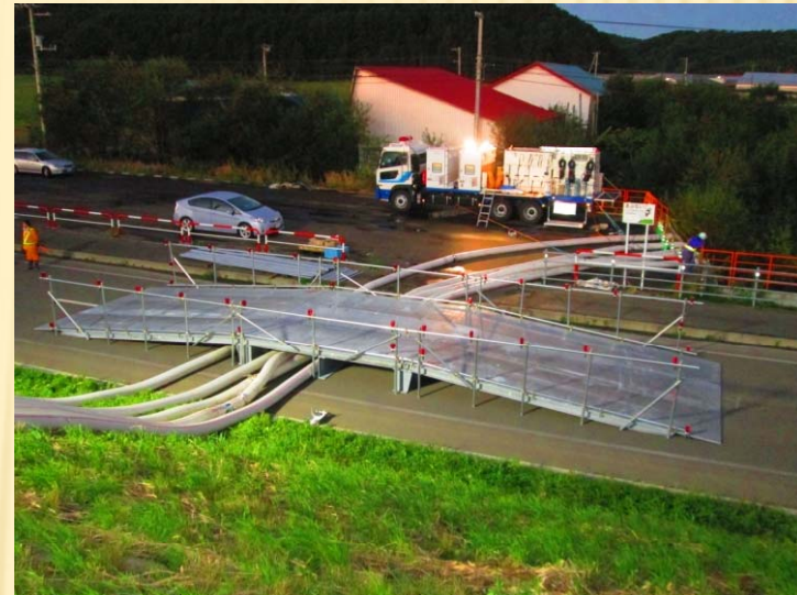
道道320号(旅来豊頃停車場線)を排水ホースが横断するため仮橋を豊頃町が設置し、排水ホースを開発局で設置
