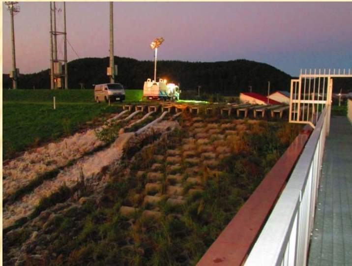
排水状況および照明状況
