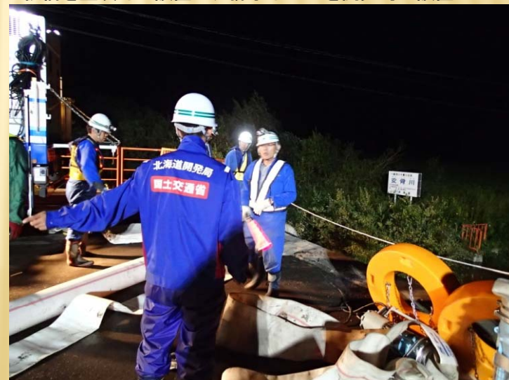
道道320号(旅来豊頃停車場線)を排水ホースが横断するため仮橋を豊頃町が設置し、排水ホースを開発局で設置
