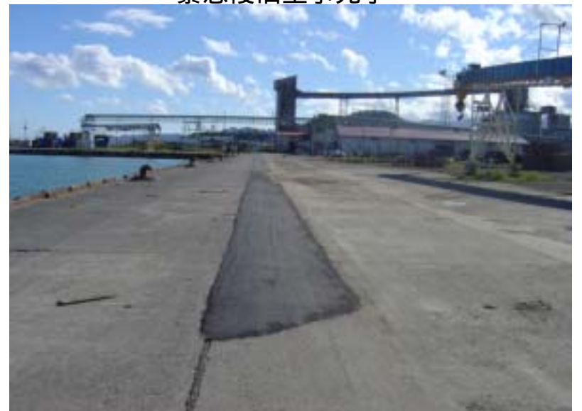
緊急復旧工事完了
