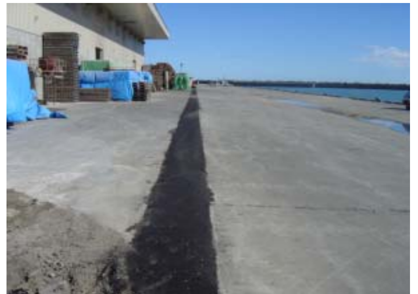
緊急復旧工事完了
