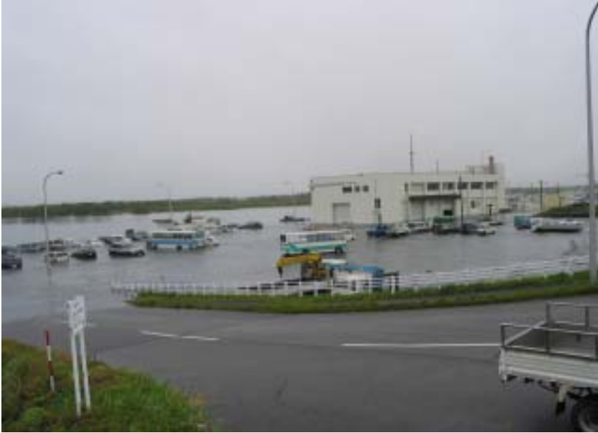
津波による漁港内冠水状況(撮影:豊頃町・大津漁協)
