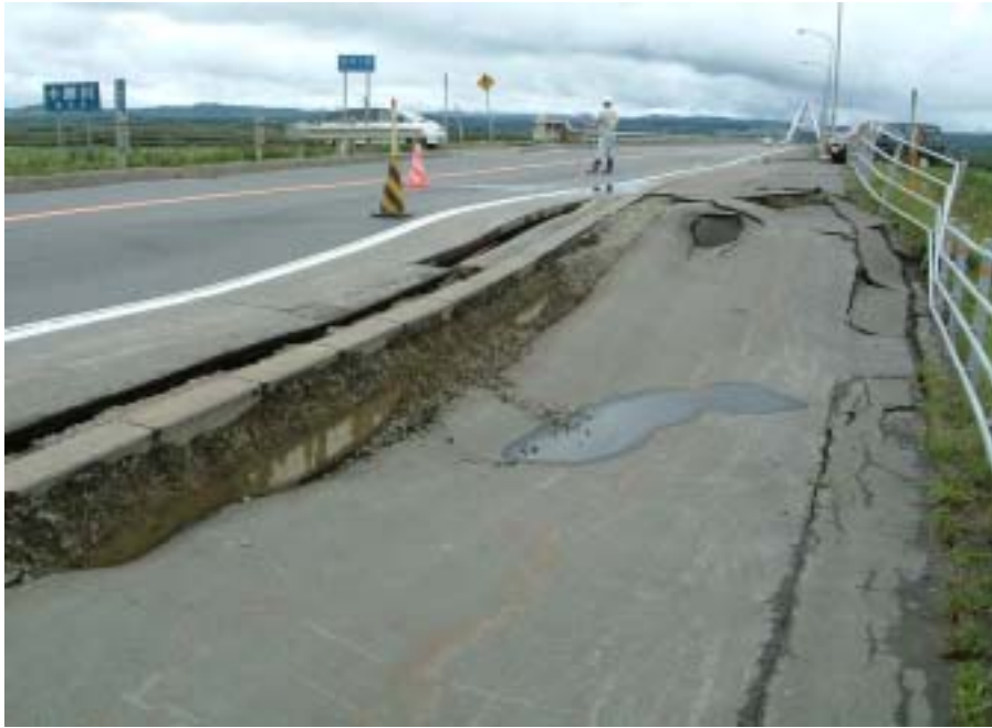
R 3 8 豊頃大橋(帯広側)
