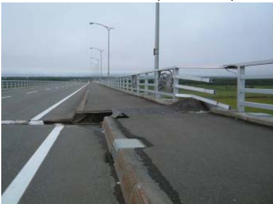
R 3 3 6 十勝河口橋(桁横移動)
