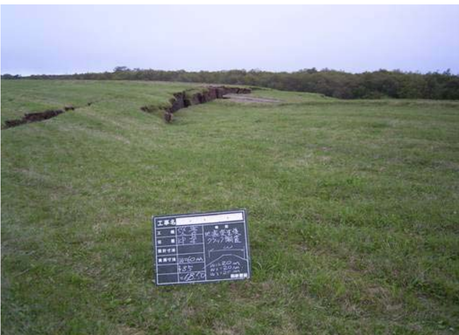
4. 十勝川左岸KP4.790～KP4.913 (十勝川左岸ウツナイ樋門下流地先緊急災害復旧工事) (着手前) (着手後)
