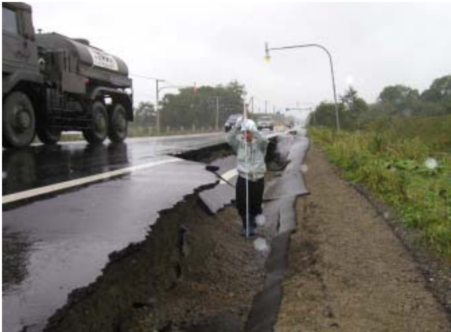
R 3 8 豊頃町幌岡避讓車線
