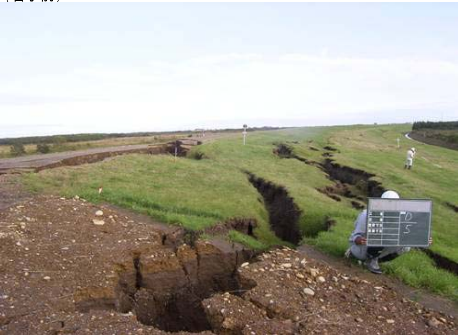
2. 十勝川右岸KP4.129～KP4.453 (十勝川右岸大津樋門上流地先外緊急災害復旧工事) (着手前) (着手後)
