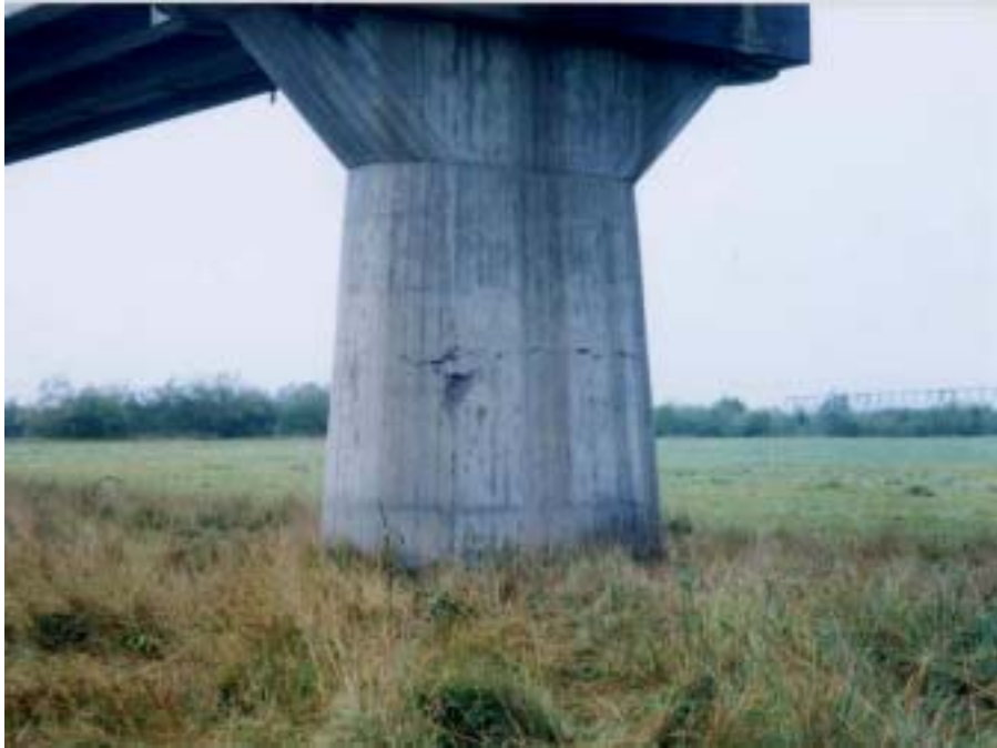
R 2 4 2 千代田大橋(橋脚)
