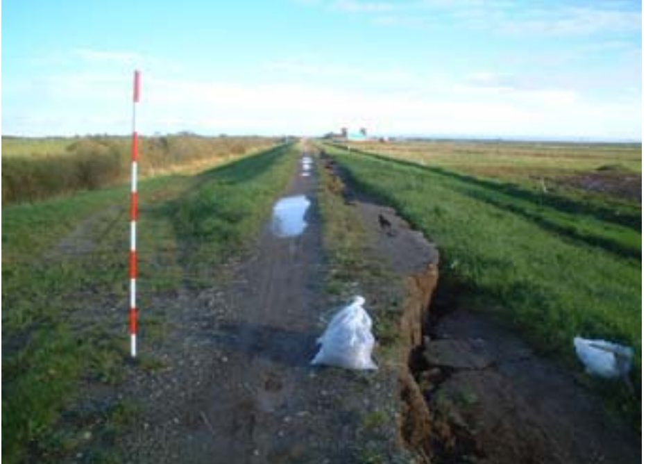
16 下頃辺川右岸KP2.000 ~ KP2.065 (下頃辺川右岸浦幌導水門下流地先外緊急災害復旧工事) (着手前)
