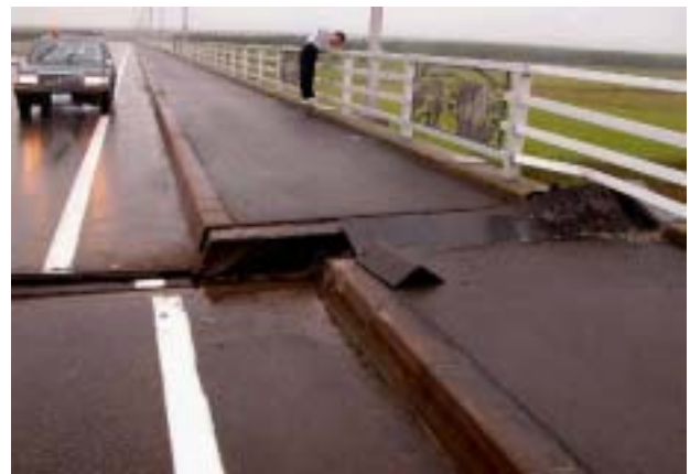
R 3 3 6 十勝河口橋(桁横移動)
