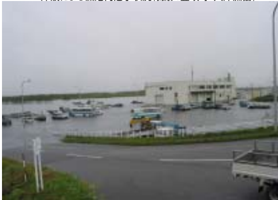
津波による漁港内冠水状況(撮影:豊頃町・大津漁協)
