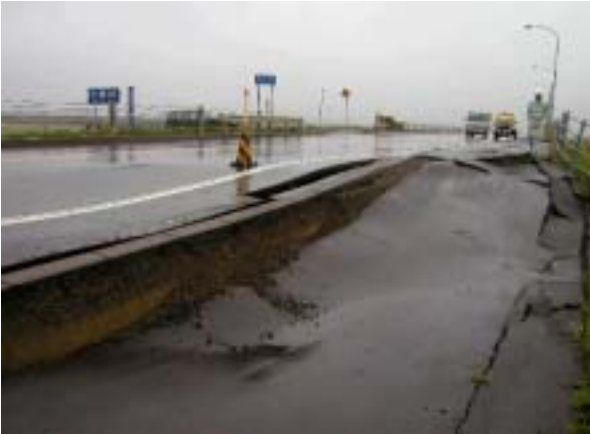
R 3 8 豊頃大橋(帯広側)
