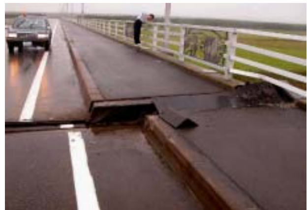
R 3 3 6 十勝河口橋(桁横移動)
