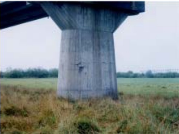
R 2 4 2 千代田大橋(橋脚)
