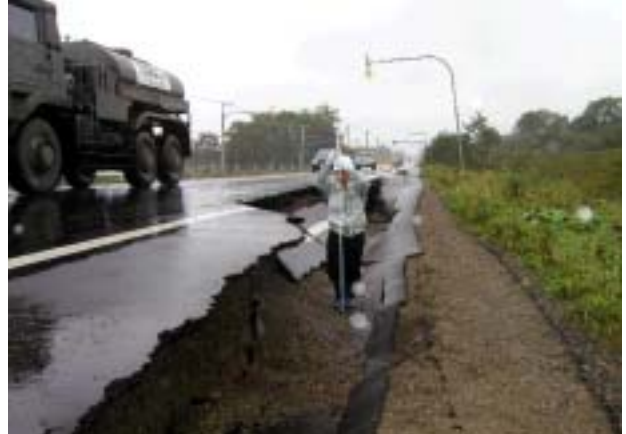
R 3 8 豊頃町幌岡避讓車線
