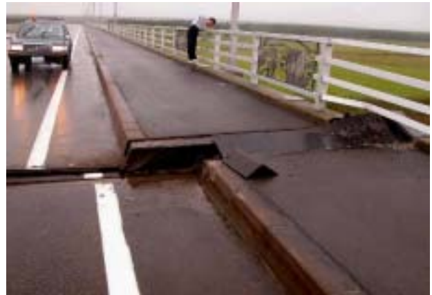
R 3 3 6 十勝河口橋(桁横移動)
