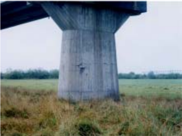
R 2 4 2 千代田大橋(橋脚)
