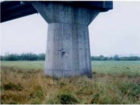
R 2 4 2 千代田大橋(橋脚)
