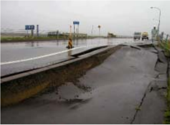
R 3 8 豊頃大橋(帯広側)
