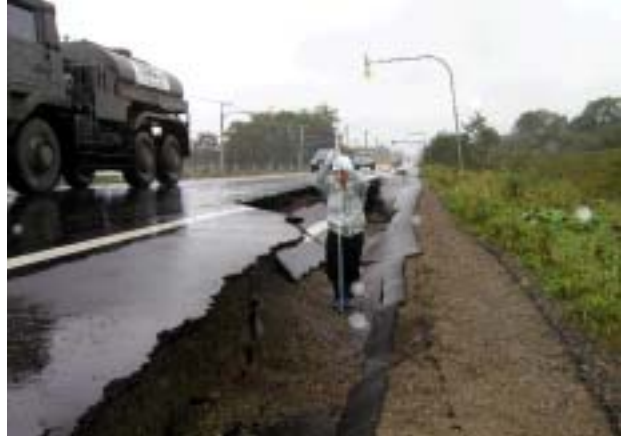
R 3 8 豊頃町幌岡避讓車線
