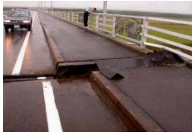
R 3 3 6 十勝河口橋(桁横移動)
