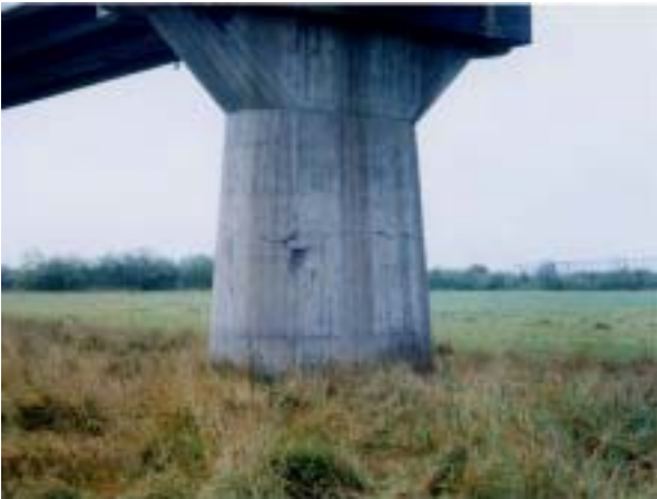
R 2 4 2 千代田大橋(橋脚)
