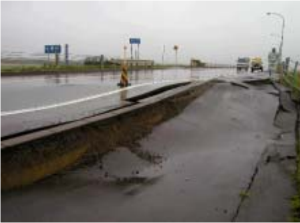
R 3 8 豊頃大橋(帯広側)
