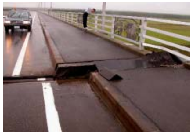
R 3 3 6 十勝河口橋(桁横移動)
