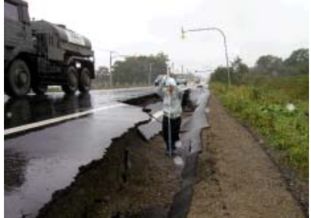
R 3 8 豊頃町幌岡避讓車線
