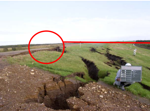
十勝川 右岸 大津築堤 河口から5.0km付近
