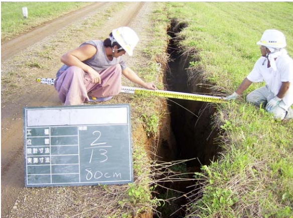
十勝川 右岸 旅来築堤 河口から13.2km付近
