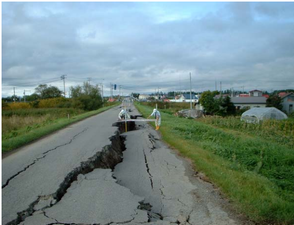
礼文内川 右岸 十勝川合流点から0.9km付近
