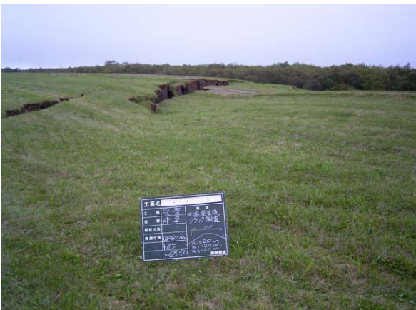
十勝川 左岸 ウツナイ築堤 河口から4.7km付近
