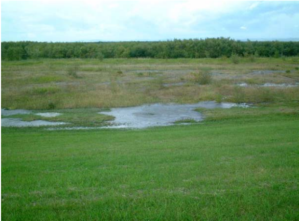
十勝川 右岸 大津築堤 堤外側 河口から3.5 km付近
