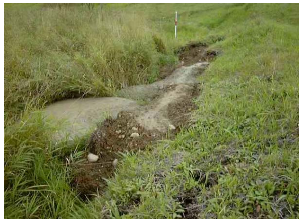
十勝川 右岸 河口から24.6 km付近
