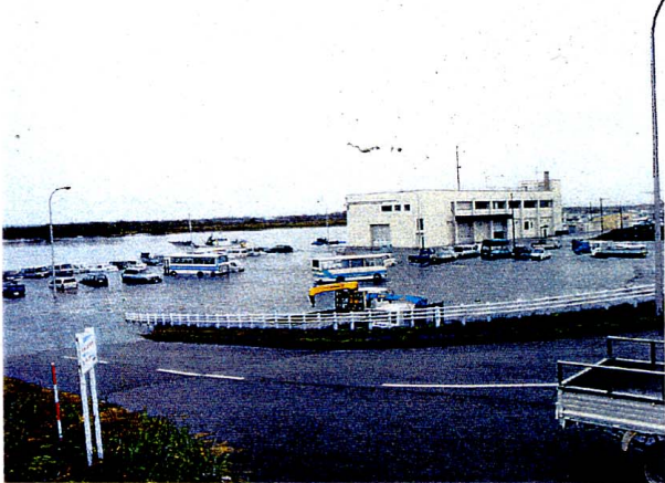
①津波による漁港内冠水状況(撮影:豊頃町・大津漁協)
