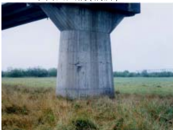
R 2 4 2 千代田大橋(橋脚)
