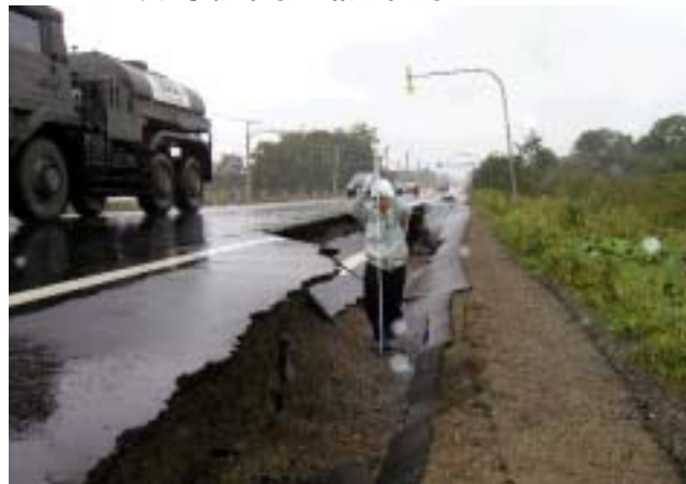
R 3 8 豊頃町幌岡避讓車線
