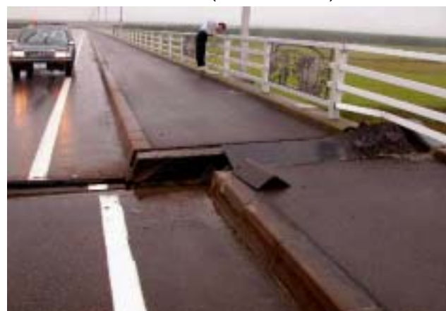
R 3 3 6 十勝河口橋(桁横移動)
