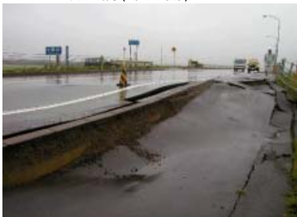
R 3 8 豊頃大橋(帯広側)
