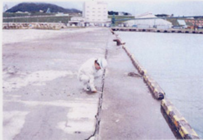
⑤ 第3小頭：上部工開工
