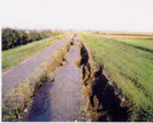
11 十勝川 青森多築堤 左岸KPO/24付近
