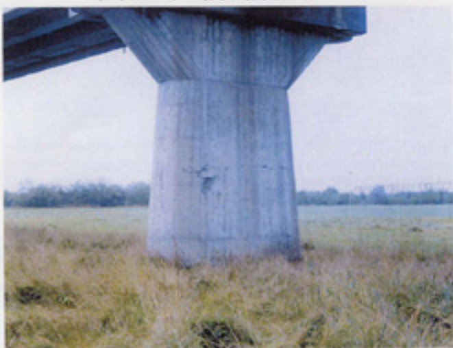
R242千代田大橋(橋脚)
