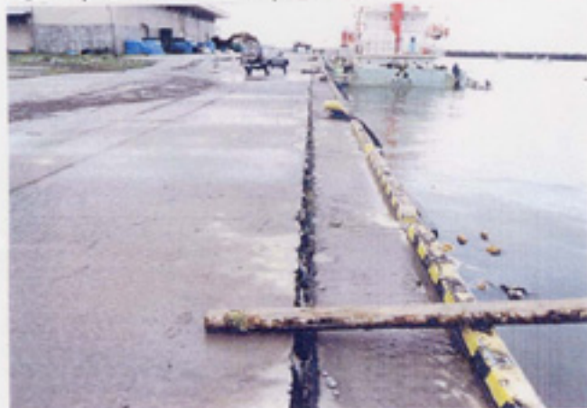
③ 第3小頭：上部工開工
