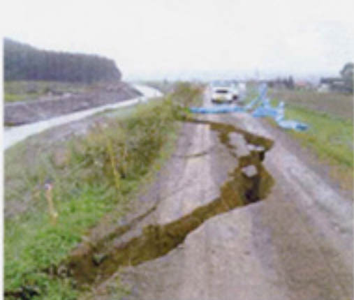
14 牛首別川 牛首別築堤 左岸 KP6/2付近
