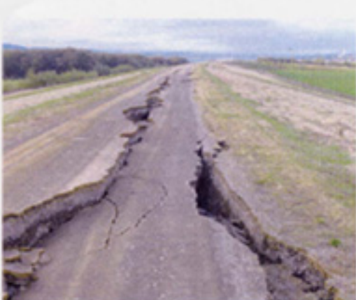
7 利別川 川合築堤 左岸 KPO/2付近
