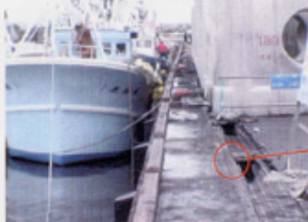
②-3. 5m岸壁：エプロン沈下
