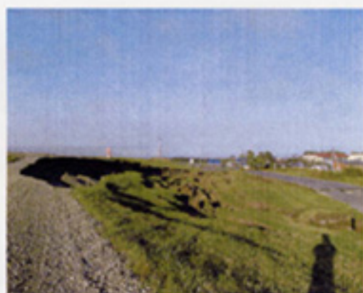
29 十勝川 大津築堤 右岸 KP3/6付近
