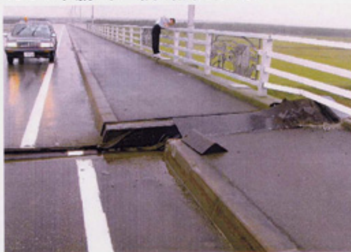
R336十勝河口橋(桁横移動)
