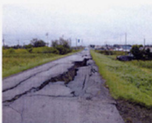
3-2 礼文内川 礼文内川築堤 左岸8/0付近
