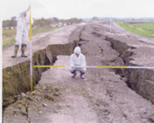
32 浦幌十勝川 浦幌大築堤 左岸 KP7/4付近
