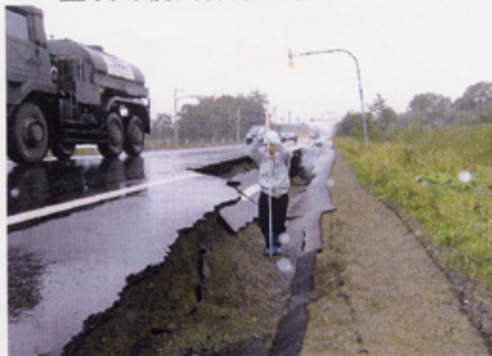
R38豊頃町幌岡非讓車線
