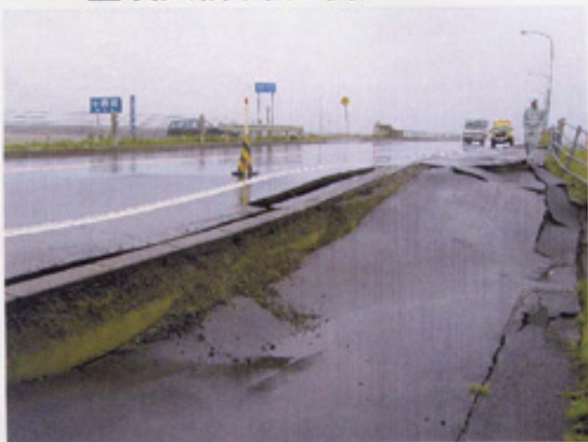
R38豊頃大橋(帯広側)
