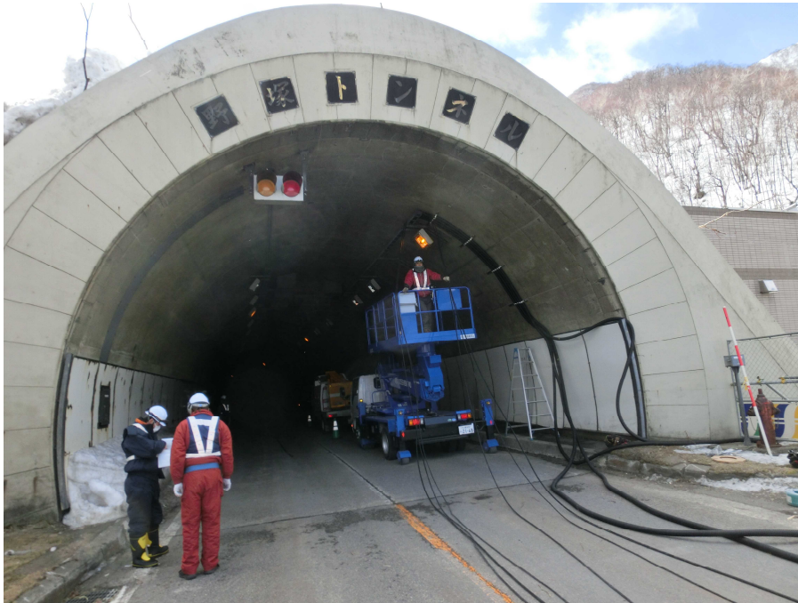
▲トンネル電源設備の応急復旧状況① (3月17日撮影)
