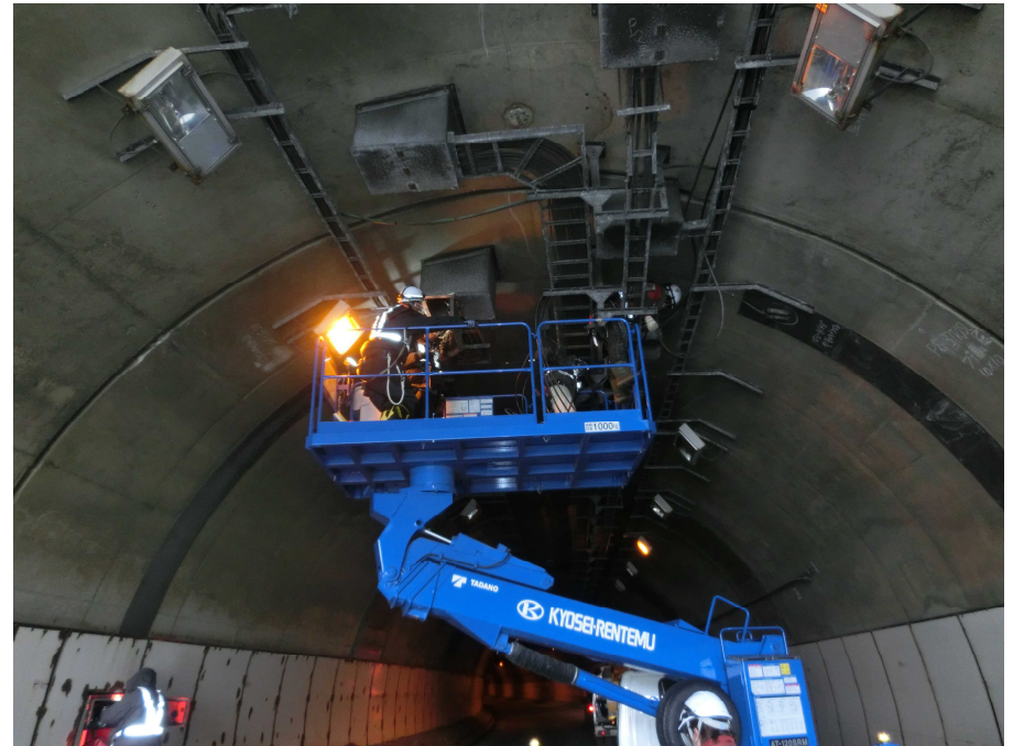
▲トンネル電源設備の応急復旧状況② (3月17日撮影)
