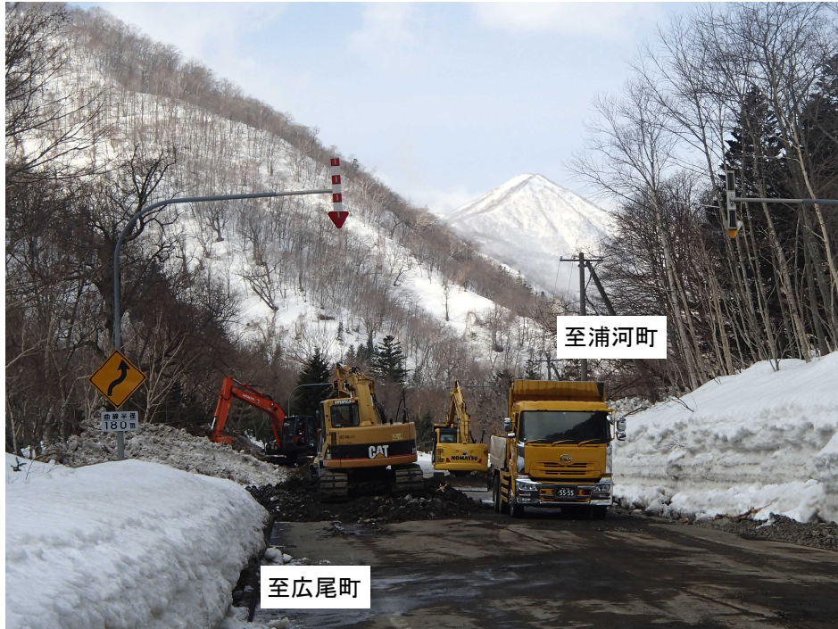
▲土砂撤去状況 (3月11日撮影)
