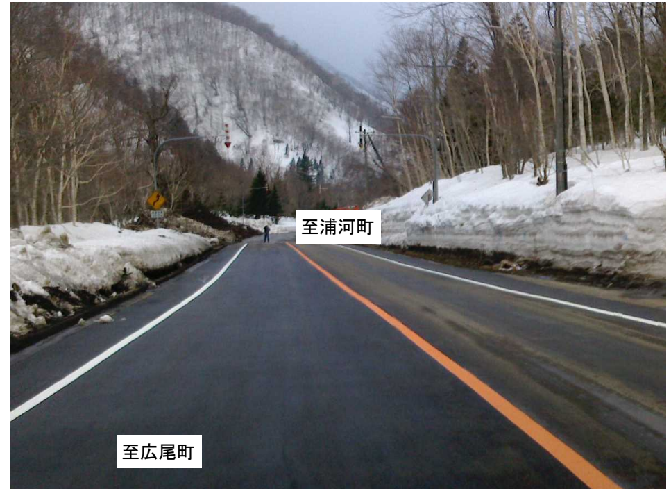
▲舗装補修完了状況 (3月13日撮影)
