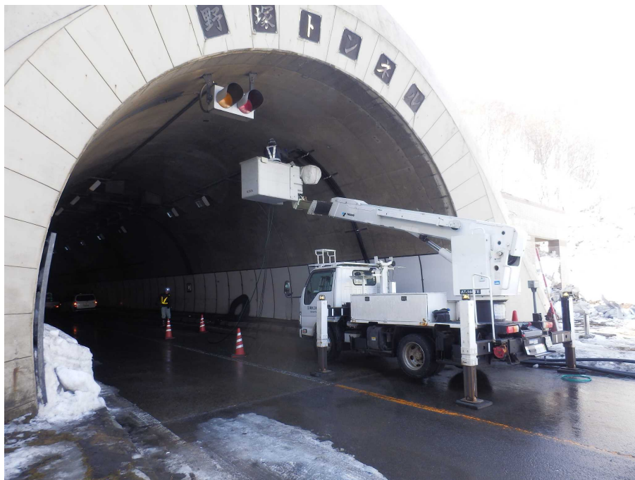
▲トンネル照明の応急復旧状況 (3月14日撮影)
