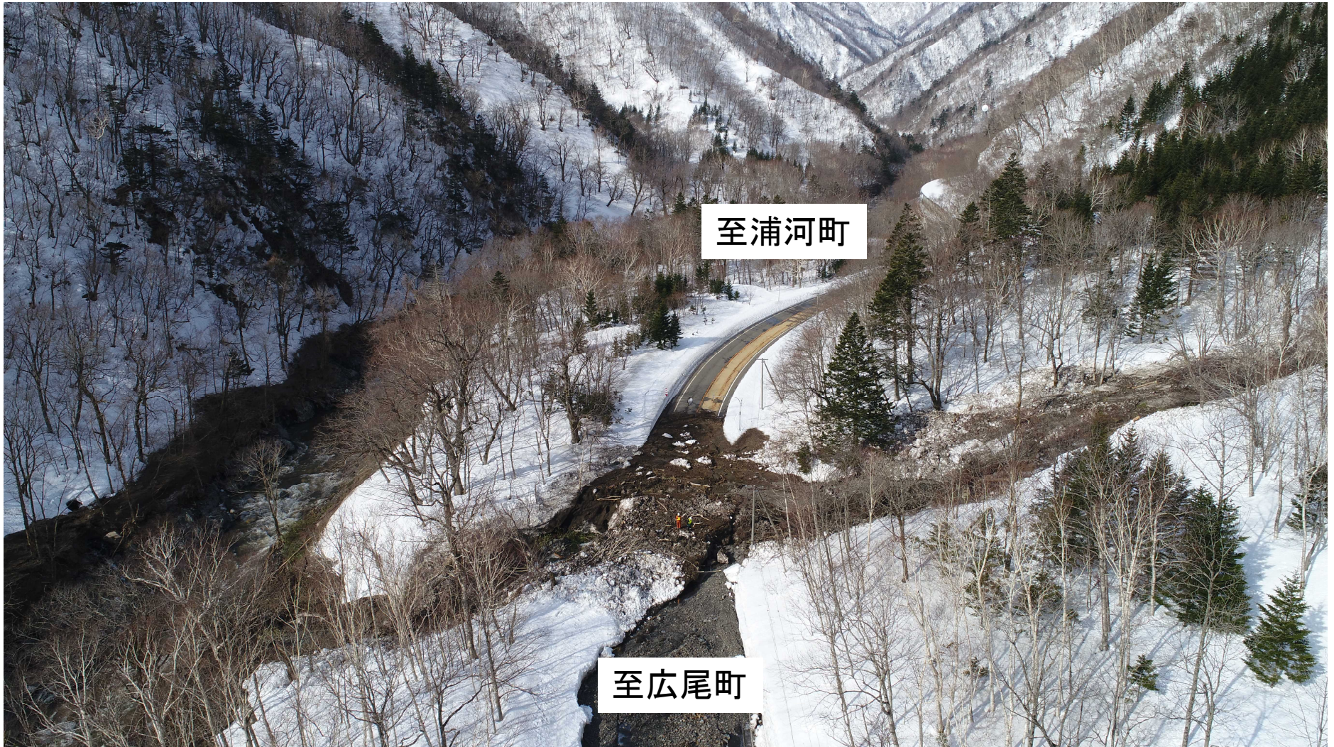
土砂流出規模 延長25m(道路進行方向延長) 幅10m(道路幅員) 厚さ2m(道路上の堆積厚) ※道路上の土砂について除去作業中
