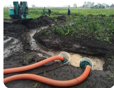
溝切り、ポンプ排水状況 平成28年8月31日撮影
