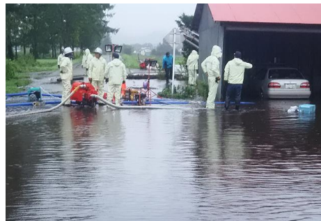
鹿追町笹川北8線 排水作業
