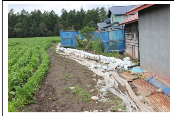
中札内村南常盤 (積み土嚢工)
