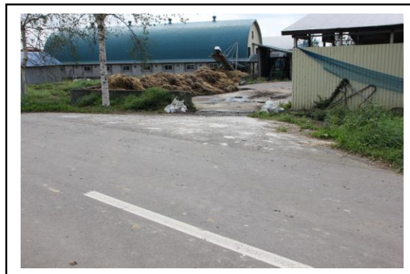
中札内村西札内 (積み土嚢工)
