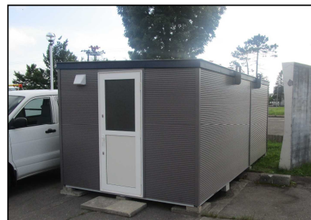
4丁目町内会防災倉庫
