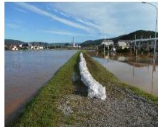
利別川左岸 土のう設置
