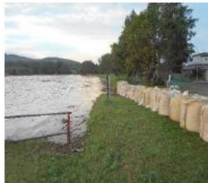
利別川右岸 大型土のう設置
