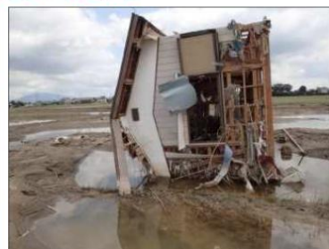
堤防決壊による家屋の倒壊
