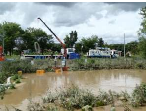
排水ポンプ車による排水作業状況
