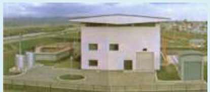
帯広排水機場
