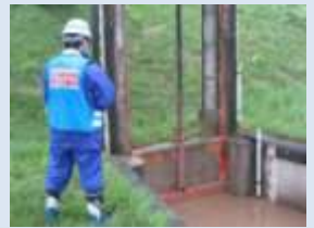
樋門閉扉確認状況
