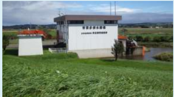
育素多排水機場
