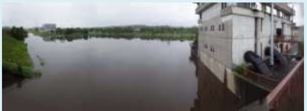
池田排水機場
