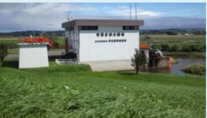
育素多排水機場
