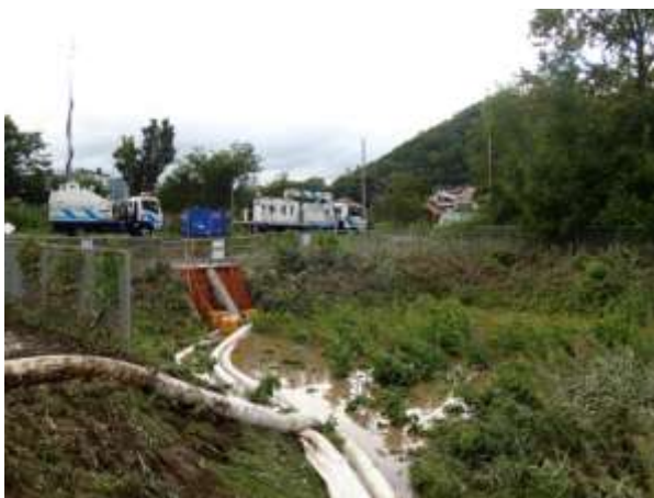
排水ポンプ車による排水作業状況
