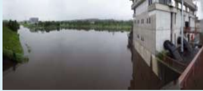
池田排水機場
