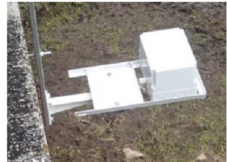
水位計設置事例
