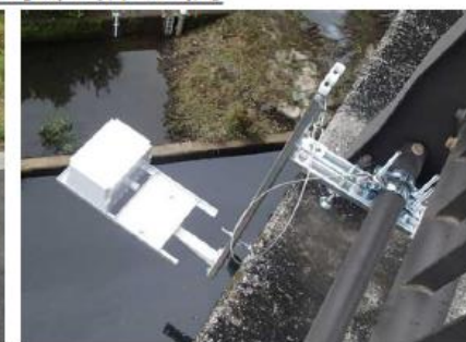
橋梁に設置するタイプ （電波や超音波で河川に触れずに計測）
