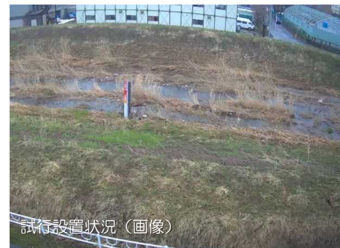
試行設置状況（カメラ本体）
