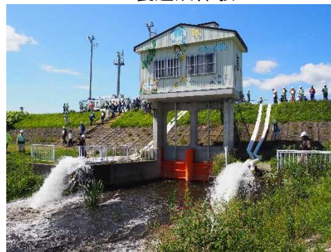
排水作業訓練（帯広開発建設部）
