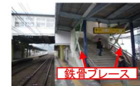
鉄骨ブレースによる駅の耐震補強
