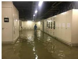
地下電源設備の浸水被害
