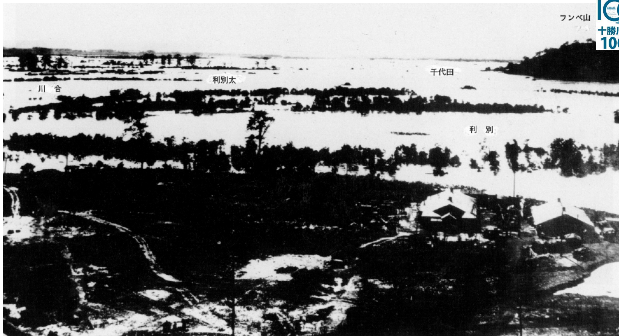
大正11年の未曾有の大洪水により甚大な被害が発生、計画の変更を余儀なくされる
