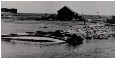
津波で転覆した漁船（豊頃町大津）
