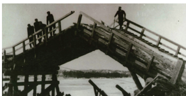
山形に折れ曲がった豊頃橋
