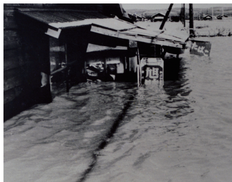
育素多築堤を溢流した十勝川の濁流（昭和 37 年 8 月 2 日～ 4 日 豊頃町中央区）
