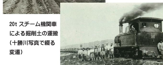
20t スチーム機関車による掘削土の運搬（十勝川写真で綴る変遷）
