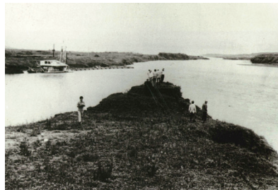
川合新水路（昭和31年通水）
