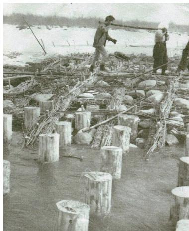
昭和35年からは並杭水制工（写真=左）を実施して流量の減少を図り、昭和38年の仮締切には土俵約2万袋、延べ800人が12日間にわたり従事しました（写真=右）。
