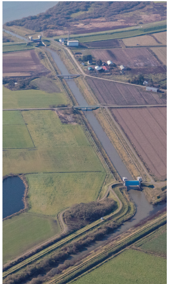
浦幌十勝導水路 全景
