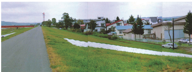
宅地化された排泥跡地 現在の池田町西3条6～7丁目
