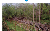
水制工による 高水敷化
