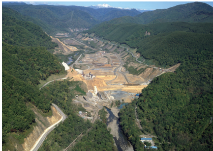
建設中の十勝ダム（昭和53年）
