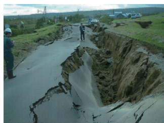
河川堤防の縦断亀裂（H15 大津築堤）
