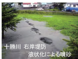
河川堤防の液状化現象
