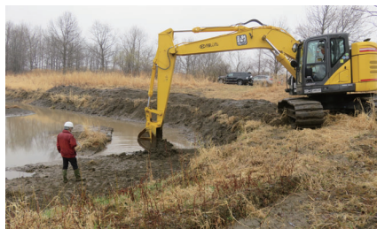
堆積土砂の掘削 (平成31年)
