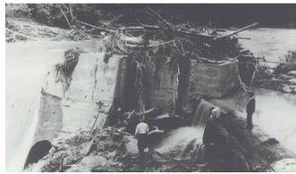
土砂により埋没した発電ダム(昭和30年7月)
