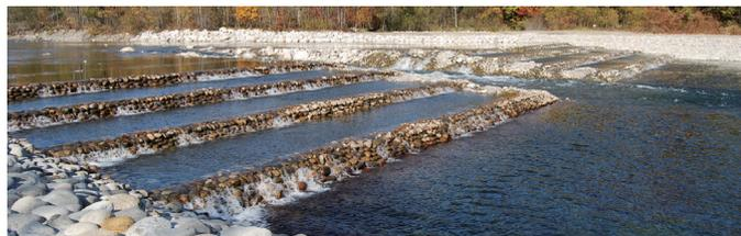
床固工は、河床の浸食や河道に堆積している不安定土砂の再移動を抑えるとともに、河道の乱れを整えて河岸の浸食や崩壊を防ぐことを目的としています。特に川が急流の場合にはいくつもの床固工をつくる「床固工群」と呼ばれる方法をとります。
