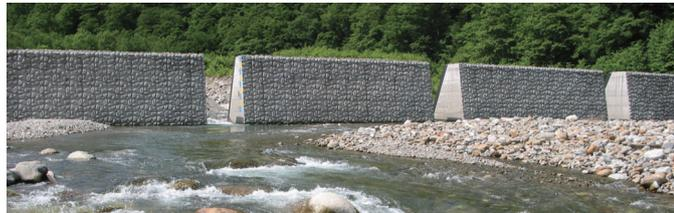
砂防堰堤は、その背後に土砂を貯めることで、川底の浸食や山腹の崩壊を防ぐとともに、一度に大量の土砂が流出することを防ぎます。最近ではスリット型(透過型、写真=上)の砂防堰堤がつけられており、ふだんは土砂が流れ、洪水時に土石流を食い止めることができます。
