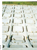
間詰コンクリート 打設前
