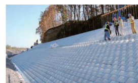
護岸ブロックの敷設
