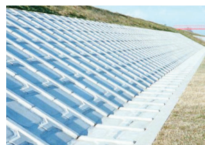
間詰コンクリート間詰完了
