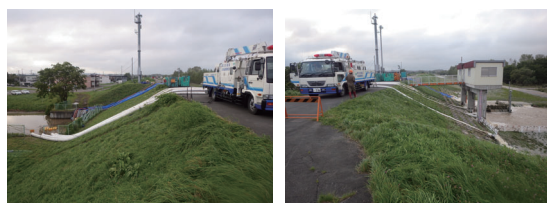
H28 排水ポンプ車による排水（左：市街地側、右：川側）
