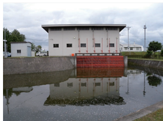
排水ポンプ場
