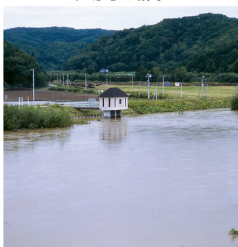
増水時の樋門。水中で門扉閉鎖
