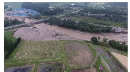
平成28年8月洪水 清見橋 被災状況(国道38号線)
