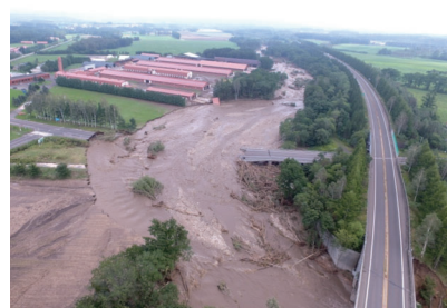
平成28年8月洪水 小林橋 被災状況 (国道38号線)
