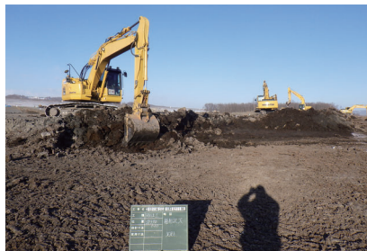
重機による河道掘削
