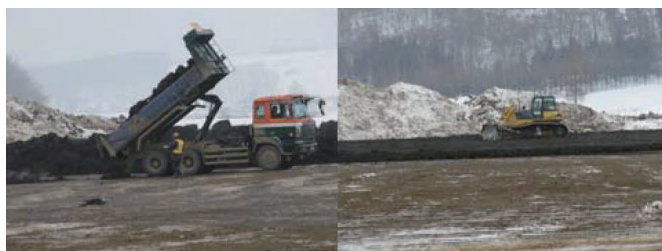
泥炭の農地への客土施工状況
