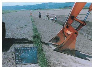
油圧ショベル法面仕上
