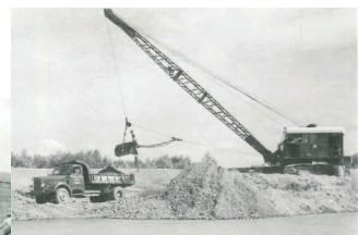
ドラグライン掘削
