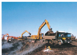
油圧ショベルによる掘削積込
