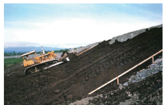
ブルドーザによる法面覆土
