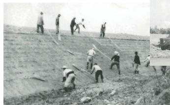
人力法面仕上
