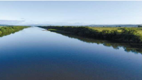
全長15.2kmの雄大な十勝川統内新水路。23年度土木学会選奨土木遺産に認定
